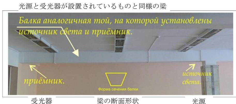
図 2. 光源とターゲットが設置されている梁の外観
